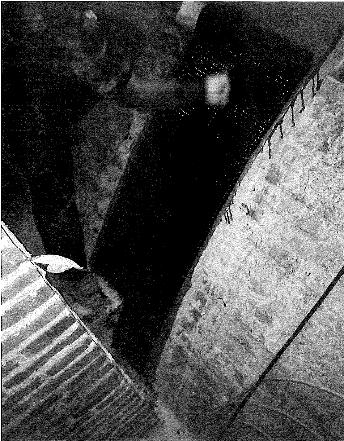
Foto n° 5 - consolidamento estradossale delle volte a corciera con la tecnica del carbonio, stesa delle matrici di carbonio di tipo bi-direzionale.
