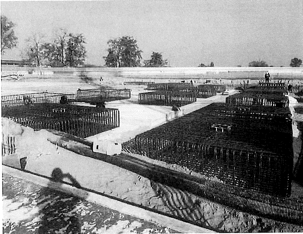
Foto n° 2 Opere strutturali di fondazione edificio Lotto n°1 – Cittadella dello Sport
