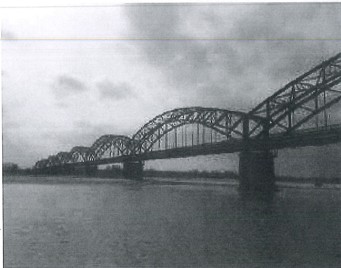
Foto n° 1 Ponte della Gerola (PV)
