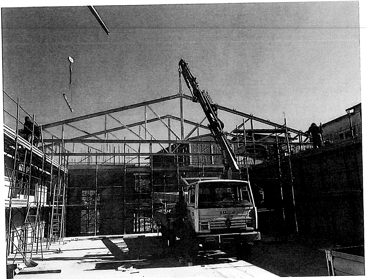
Foto n° 1 Montaggio in opera di capriata metallica avente luce L=16,00 mt
