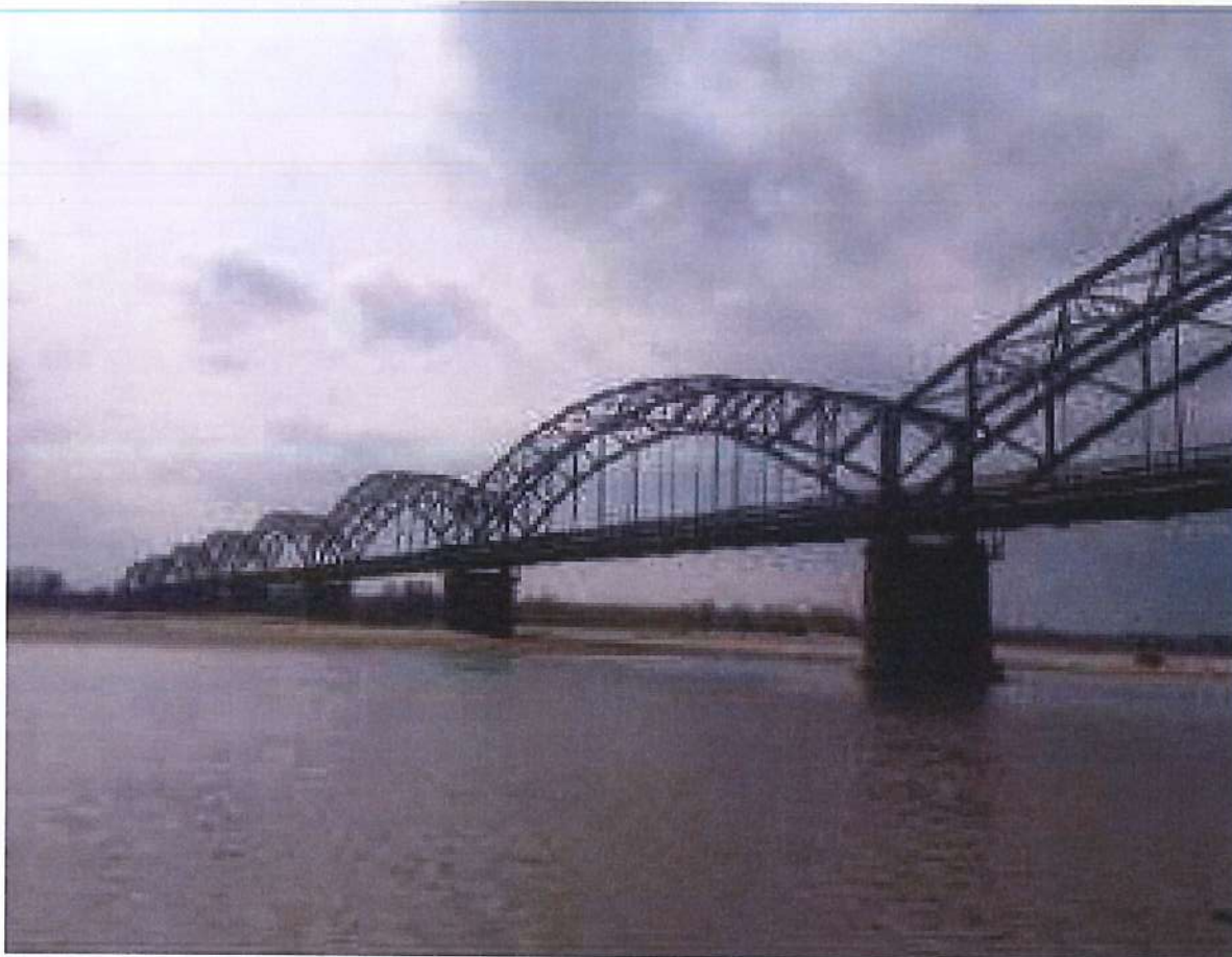
Foto n° 1 Ponte della Gerola (PV)
