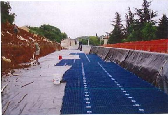
*interventi di mitigazione idraulica in bacini interrati*
