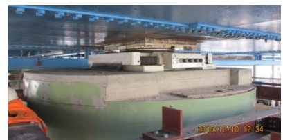
Adeguam. sismico V.tto Capodichino (NA)
