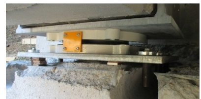
Interventi di adeguamento sismico A10
