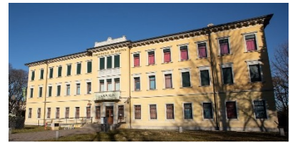
Manutenzione straordinaria copertura complesso ESAPOLIS (PD)
