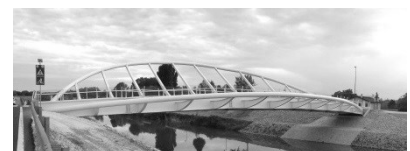
Passerella sul Canale S.Gregorio a Padova
