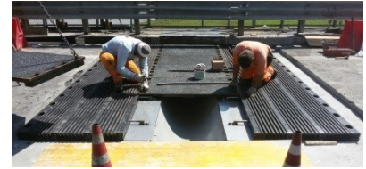
Sostituzione Giunti Viadotti SS38
