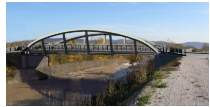
Nuovo ponte sul fiume Guà su SP33
