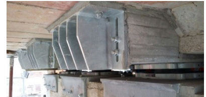
Interventi di adeguamento sismico A10 (V.tti Taggia – S.Romolo – Rio Foce)
