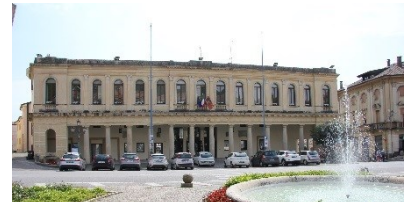
Lavori di miglioramento sismico del Comune di Valdobbiadene (TV)
