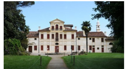
Miglioramento sismico Villa Guidini (TV)
