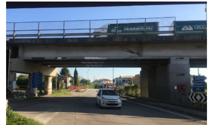
Viadotto sulla SP111 Gasparona (VI)
