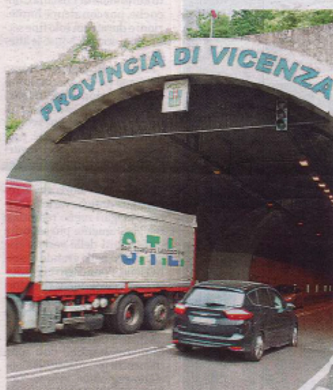
Tunnel/Installazione di cavi ultrasensibili per rilevare gli incendi Archivio
