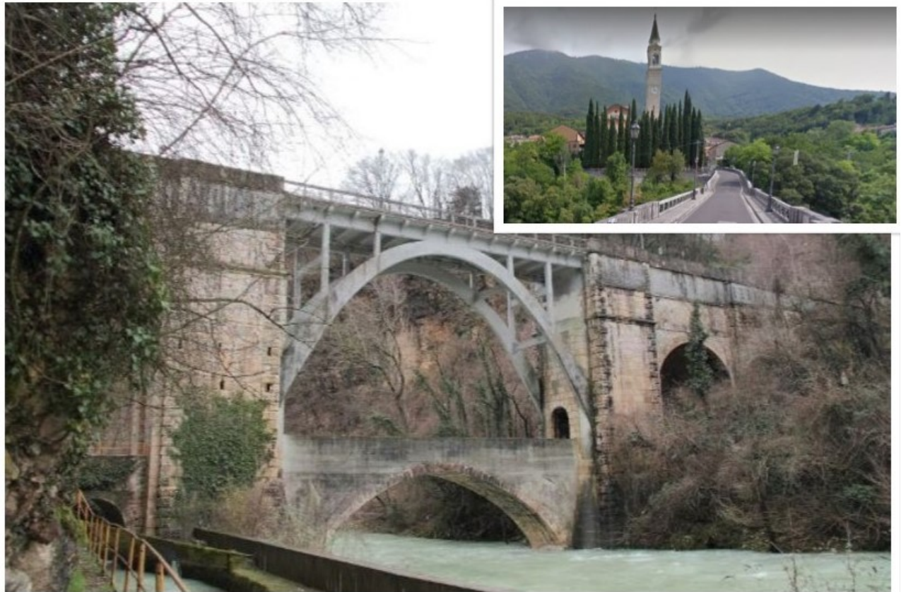
Il Ponte Vecchio che porta al centro del paese di Caltrano, con una portata d'acqua "regolare"
